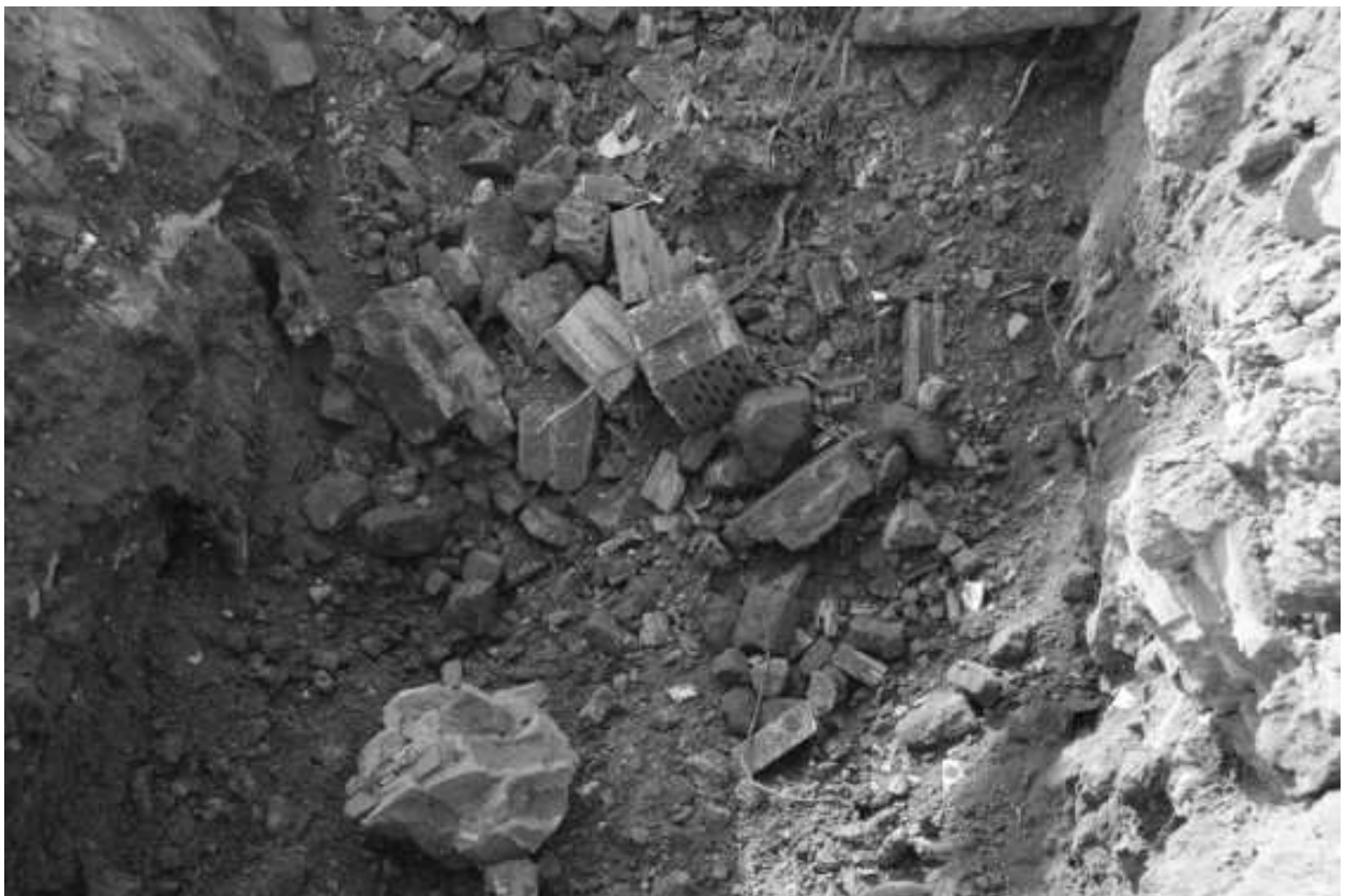
Sonda 2 – výkop obsahuje m.j. kusy cihelného zdiva, dráty, kusy železa
