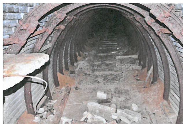
Foto 6 – štola Lazec II, úvodní část
