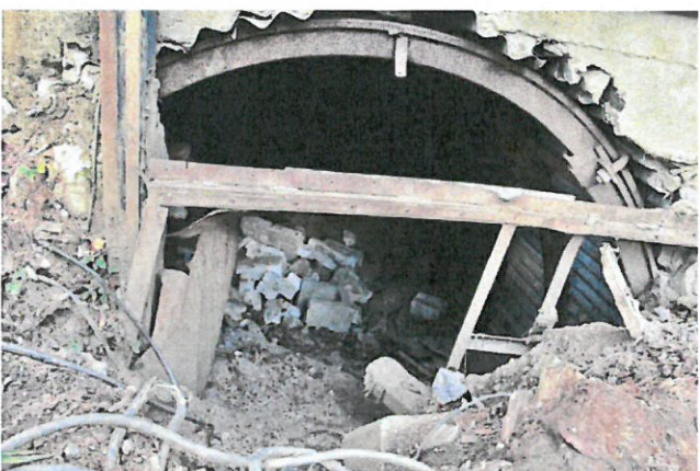
Foto 5 – štola Lazec II, portál
