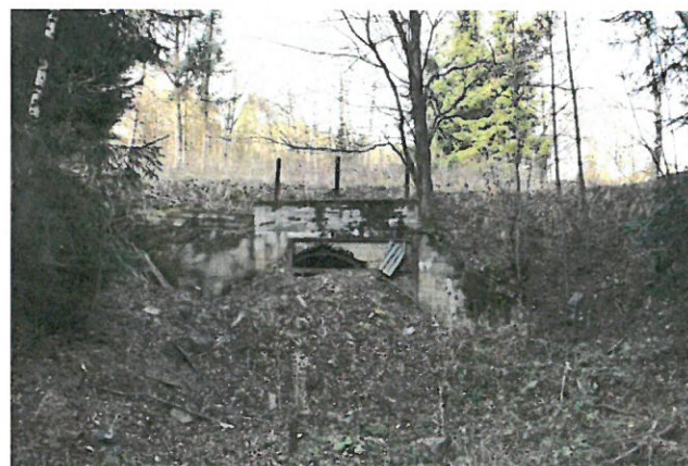
Foto 4 – štola Lazec II, portál
