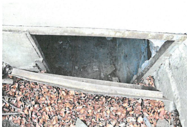
Foto 2 – štola Jan, portál
