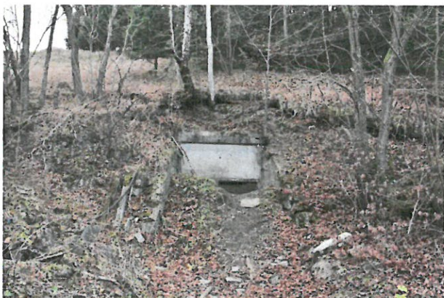
Foto 1 – štola Jan, portál
